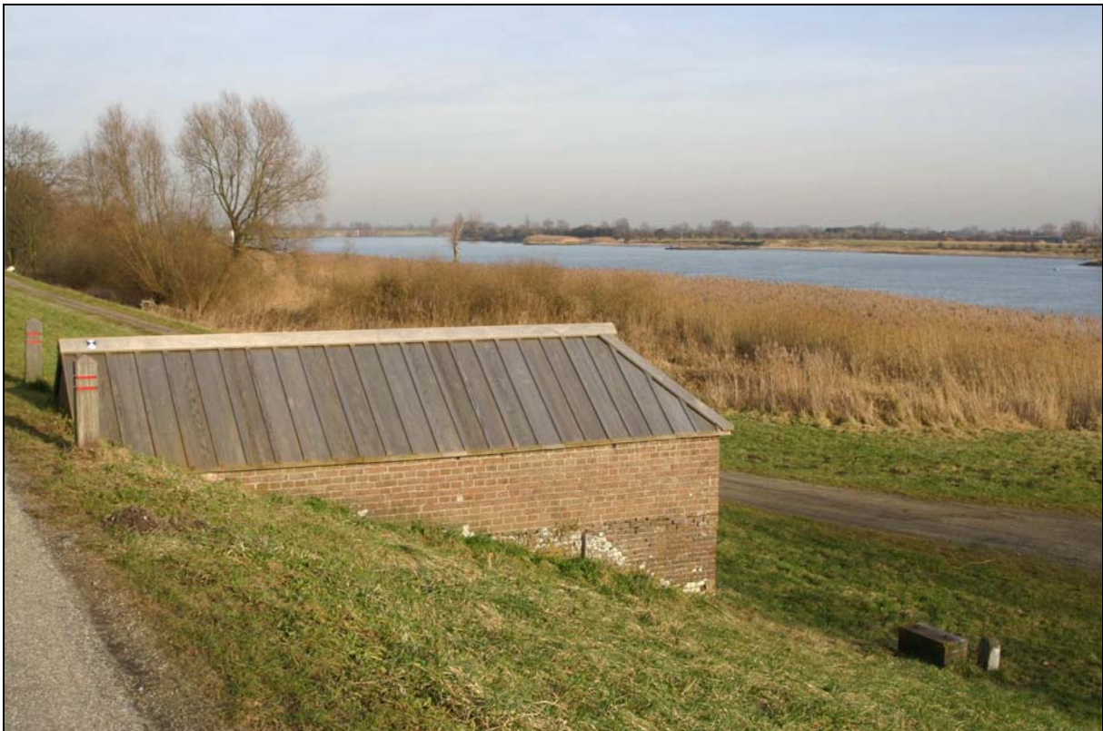
De Lek en de Lekdijk bij Jaarsveld. Op de voorgrond staat een peilschaalhuisje, waar men vroeger bij hoogwater de waterstand van de rivier opmat.
