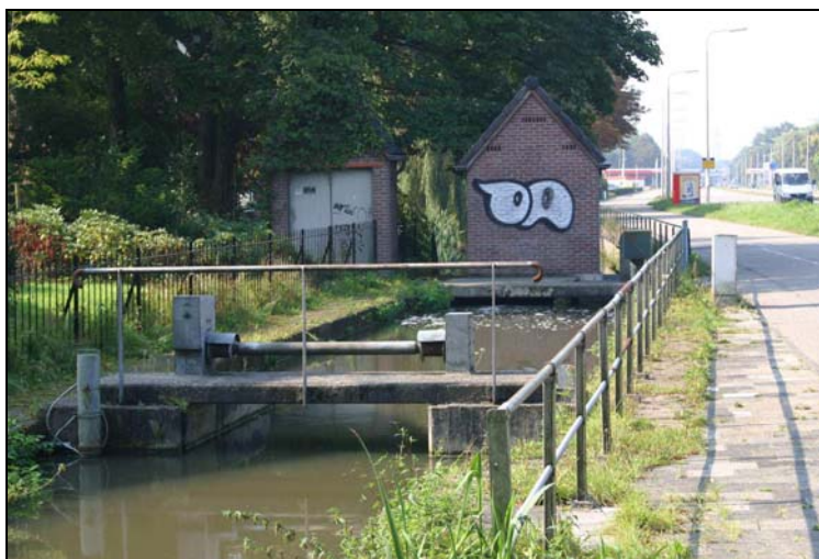
Oude schutsluis in de Biltsche Grift, waarin in 1979 een vijzelgemaal werd gebouwd ten behoeve van de wateraanvoer en verversing van de Zeister Grift en Zeist-West. De stroomrichting in de Grift werd dus omgedraaid.
