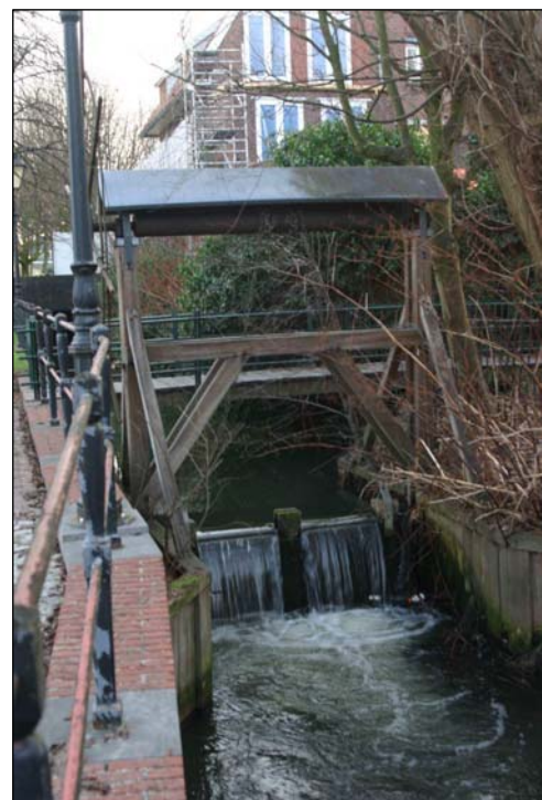
Stuw in de Oosterstroom in Utrecht.
