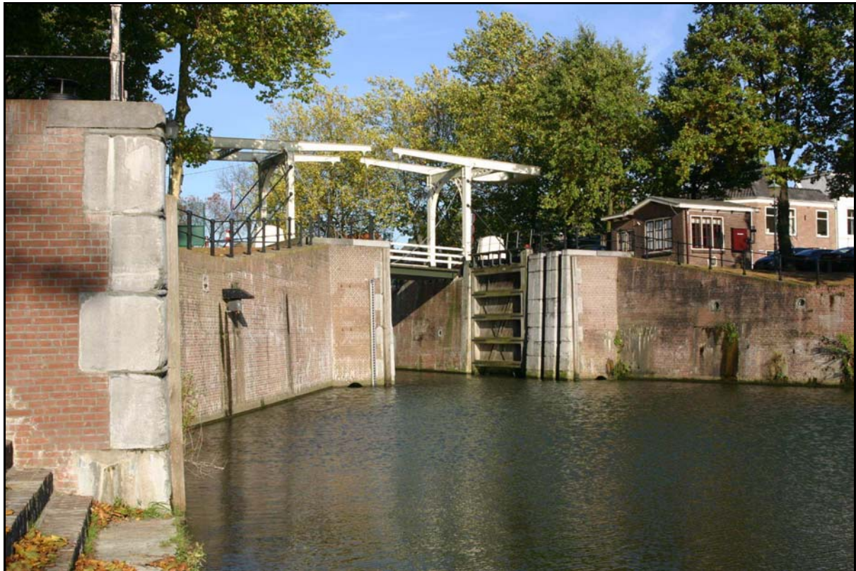
Een deel van de sluiskolk met het middenhoofd van de Oude Sluis in Vreeswijk uit 1824, gerestaureerd omstreeks 2000.
