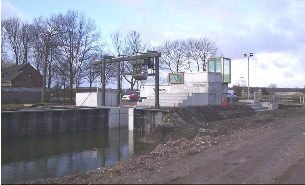
Foto van het gemaal Vleuterweide in aanbouw (januari 2006). Dit gemaal heeft een gescheiden tweeledige functie, namelijk voor het stedelijk gebied van de nieuwe Utrechtse stadswijk Leidsche Rijn en voor het landelijk gebied. Het gemaalgebouwtje dient nog voorzien te worden van een ommanteling van stalen roosters. Het geheel bestaat uit 2 vijzels (60 resp. 32 m 3 per minuut), een krooshekreiniger, 2 stuwen (alles geheel geautomatiseerd) en een de-wit-vispassage. De vispassage is genoemd naar de uitvinder Wim de Wit, medewerker van De Stichtse Rijnlanden. Het gemaal is ontworpen door De Haan Consult en A+D+P-architecten. De totale investeringskosten bedragen € 1.500.000,-. Foto: De Stichtse Rijnlanden.
