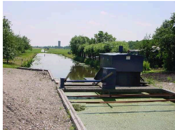
gemaal Hazenpad in Polsbroekerdam
