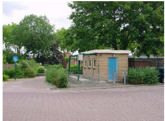
rioolgemaal a/h Kleine Bospad in Montfoort
