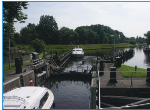
De Waaiersluis markeert de voltooiing van de kanalisatie van de Hollandsche IJssel en de overgang tussen één vast peil en getijdenwerking
