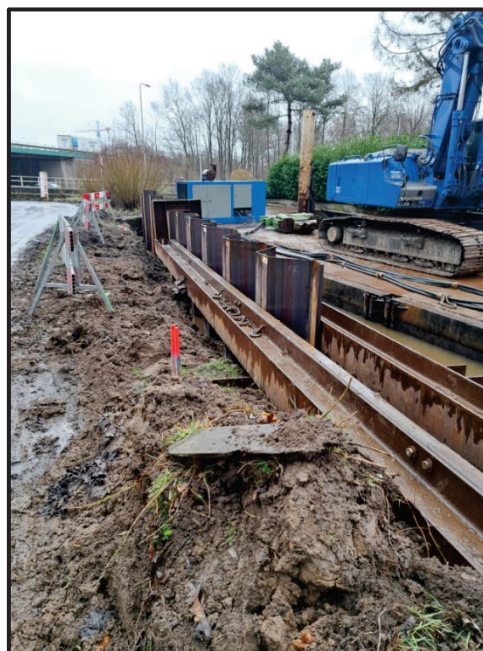
Afbeelding 8: dijkverbetering project Korte Linschoten
