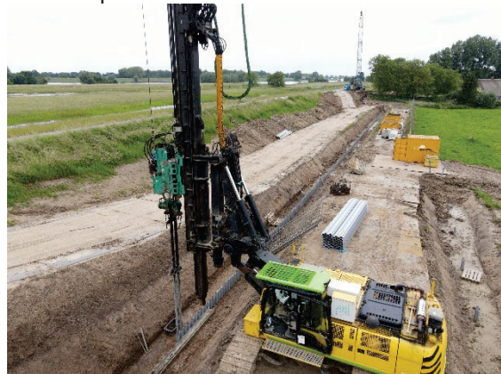
Afbeelding 4: Plaatsing innovatief filterscherm (Prolock) bij Salmsteke
