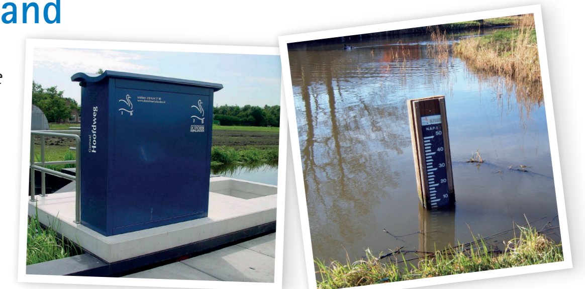
Bij veel stuwen, inlaten en kleine gemalen staan deze blauwe bedieningskastjes met 'golfdak'.
