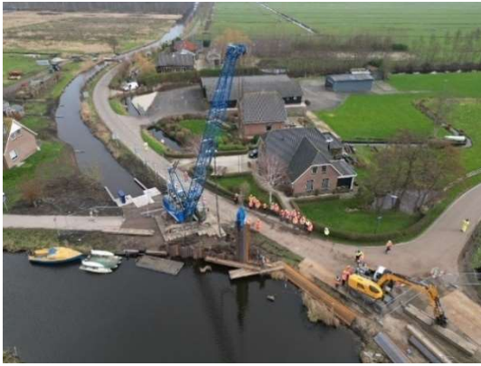
Figuur 25: Foto uitvoering verbeteren Meijekade
