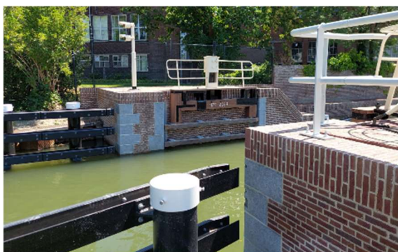
Figuur 18: Foto vernieuwde doorslagsluis
