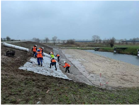
Figuur 27: Foto 'inpakken' van net versterkte dijk bij Salmsteke om de grasmatt in ontwikkeling te beschermen
