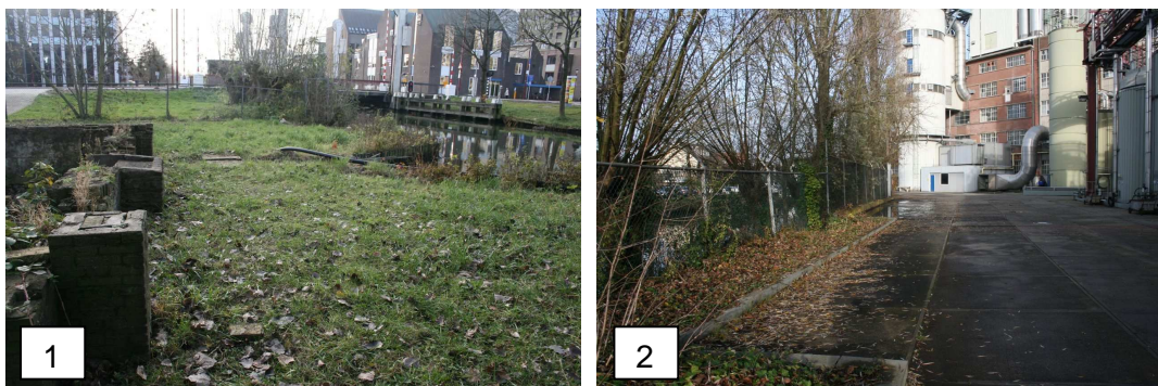
Figuur 3: Foto-impressie van kadevak 226B: de funderingsresten van het oude gemaal / de molen [1] en het bedrijventerrein [2]. Het tussenliggende groenperceel is te overgroeid om foto's van te nemen.
