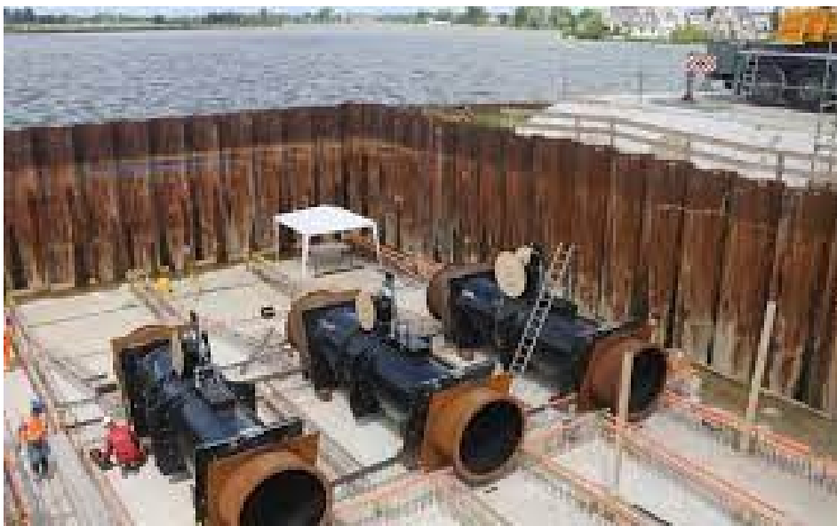
Figuur 18: Voorbeeld van 3 horizontaal opgestelde pompen in een bouwkuip
