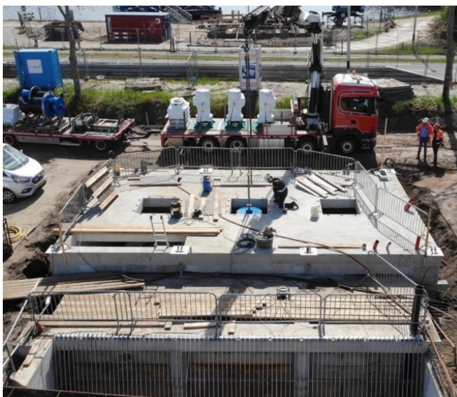
Figuur 16: Voorbeeld pompkelder met 3 verticaal opgestelde pompen en doorsnede visvriendelijke pomp
