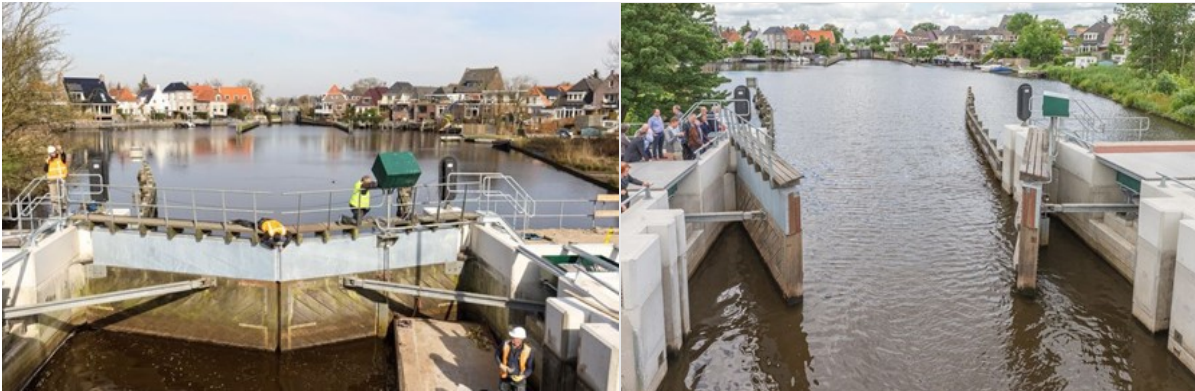
Figuur 20: Voorbeeld afsluitemiddel met puntdeuren in afgesloten (links) en open stand (rechts)
