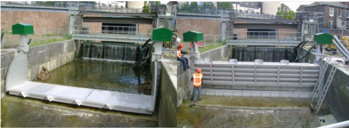
Figuur 22: Voorbeeld afsluitmiddel met klepstuw (links gestreken/open en rechts opgezet/kerend)
