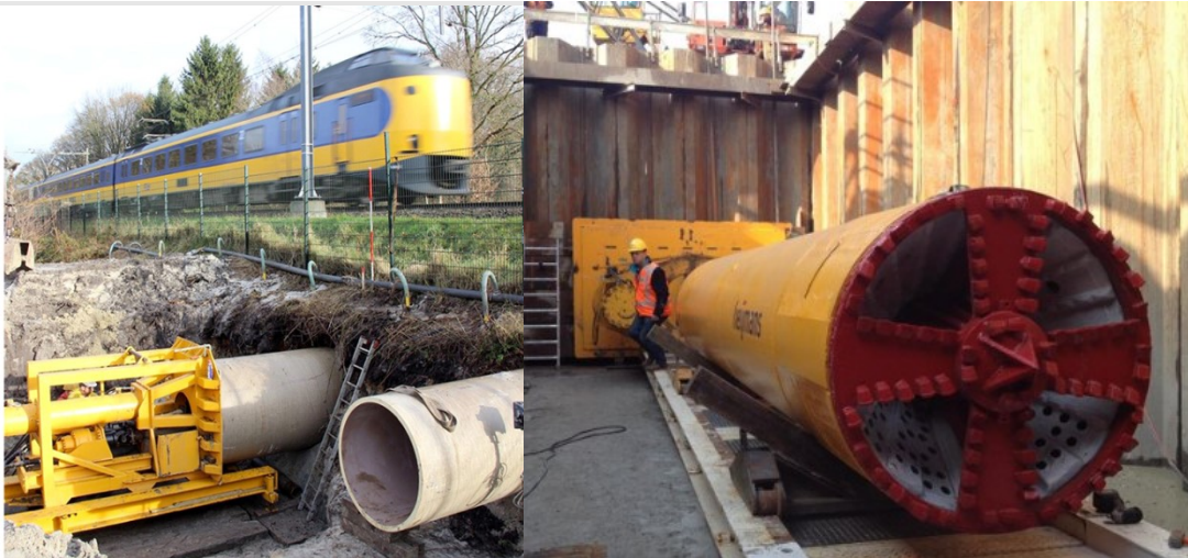
Figuur 28: Voorbeeld sleufloos aanbrengen persleiding
