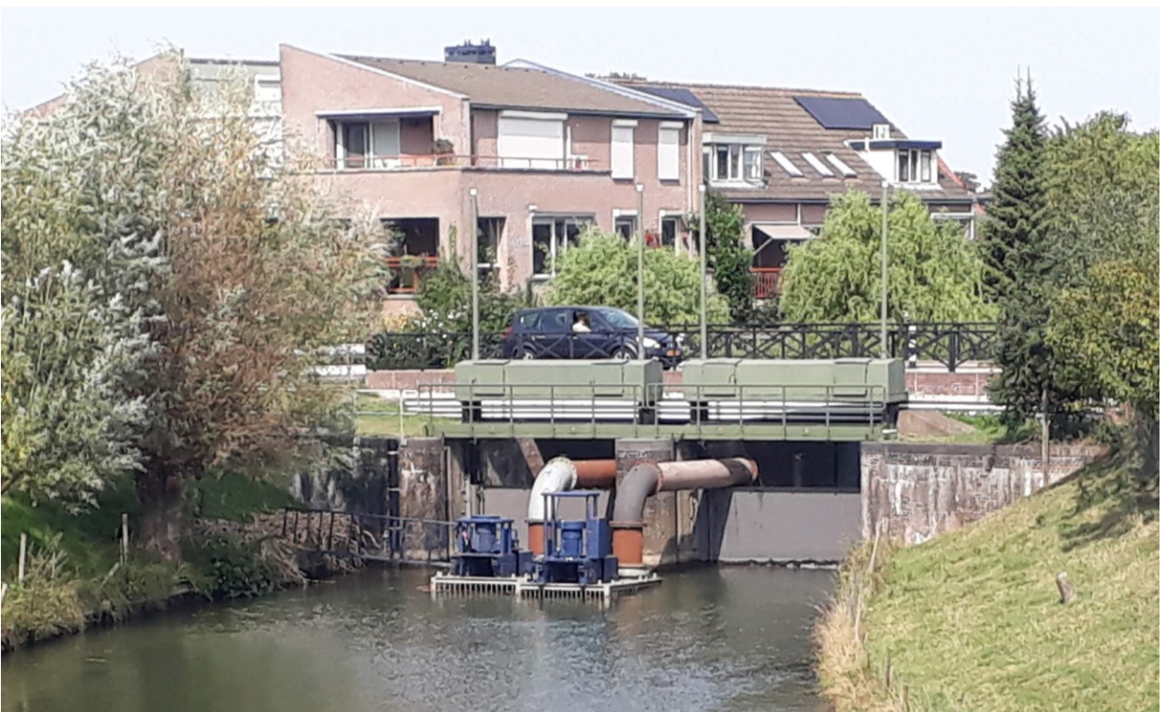
Figuur 10: Noodpompen bij inlaat Kromme Rijn
