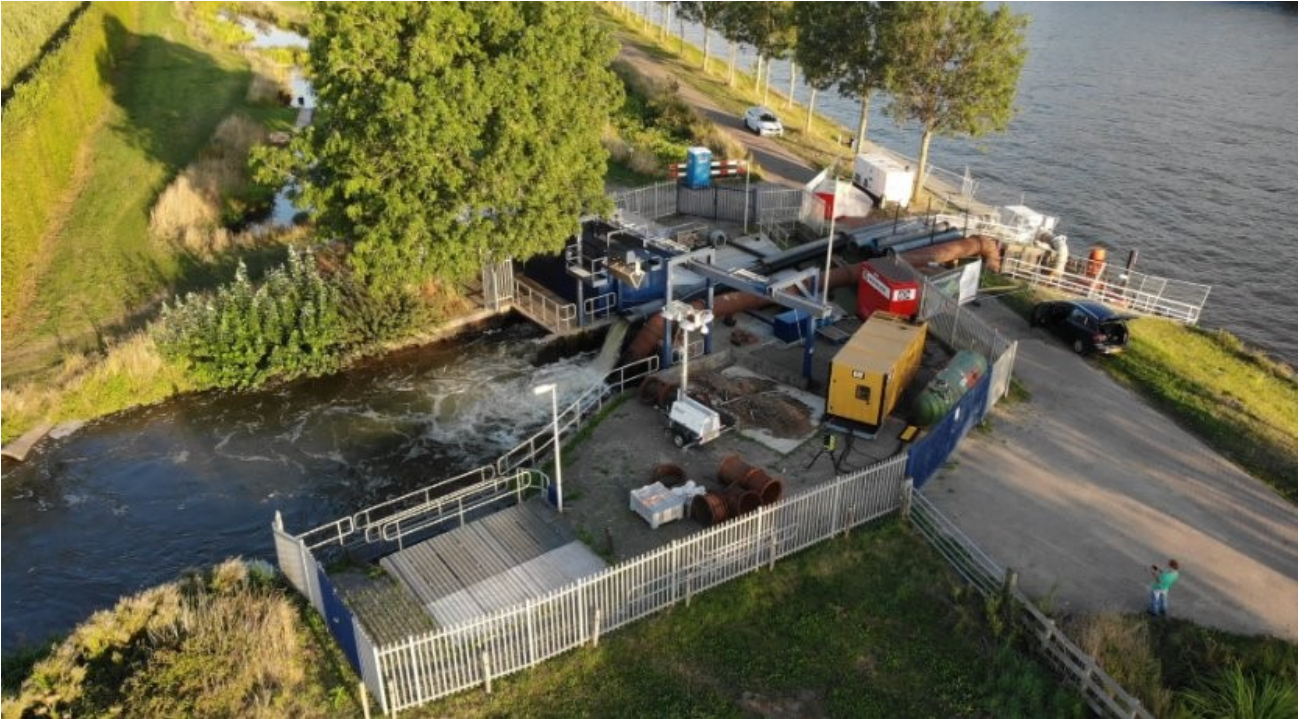
Figuur 9: Noodpompen bij gemaal Caspargouw
