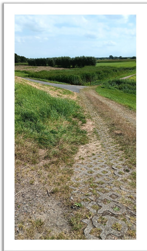
Figuur 8-2 Tegenover de weg Uitweg (in dijkvak De Kniek tot de Horde) is een buitendijkse afrit aanwezig die aan een kant geasfalteerd is; de andere kant bestaat uit grasbetontegels
