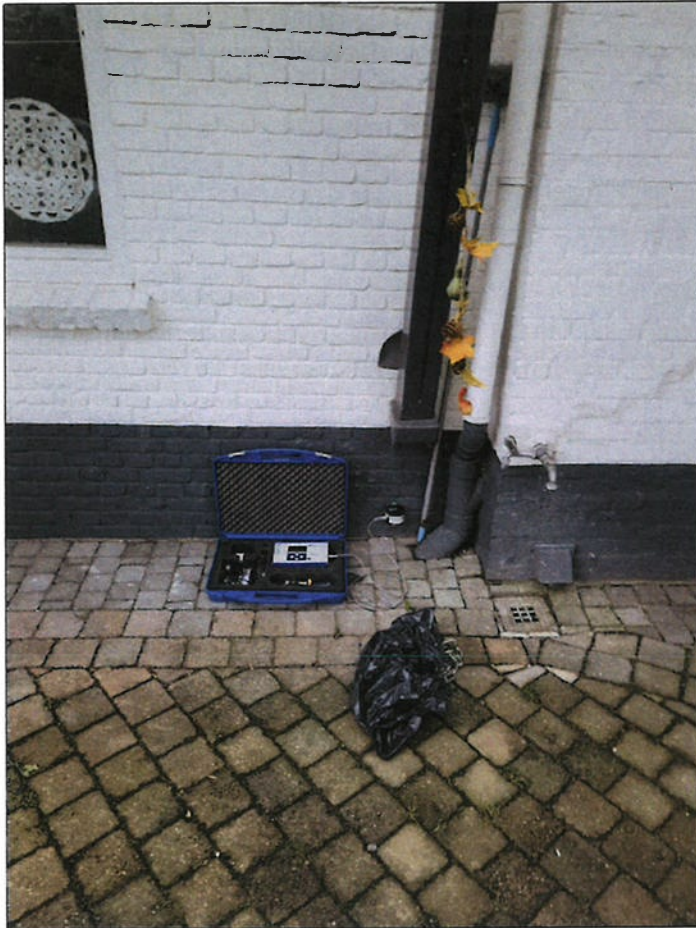
Figuur 7: Profound trillingsmeter type Vibra+ bevestigd aan gevel
