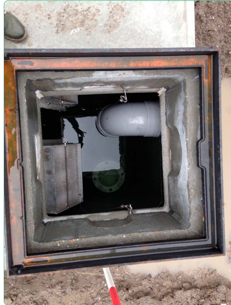
Links: het plaatsen van een olieafscheider. Een olieafscheider is vaak zo zwaar dat deze veelal met een kraan geplaatst moet worden. Rechts: bovenaanzicht van een olieafscheider.
