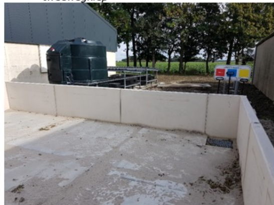
Wasplaats met zuiveringssysteem en driewegklep
