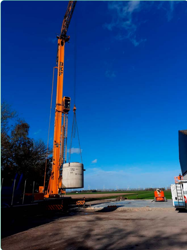
Links: het plaatsen van een olieafscheider. Een olieafscheider is vaak zo zwaar dat deze veelal met een kraan geplaatst moet worden. Rechts: bovenaanzicht van een olieafscheider.
