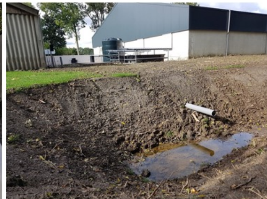
Infiltratievoorziening
