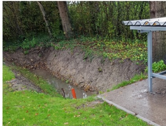
Infiltratievoorziening
