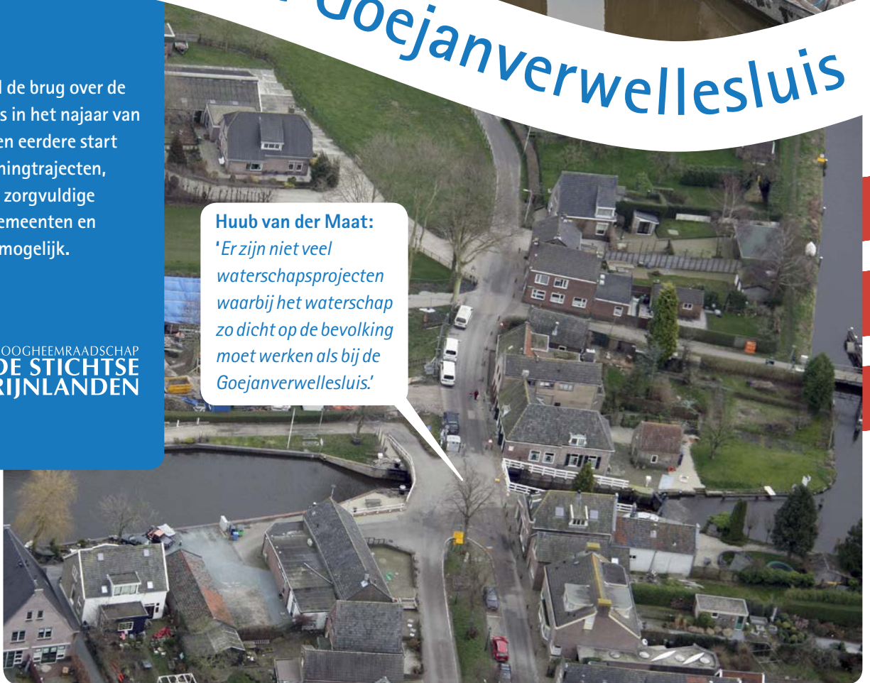
De brug en de gerenoveerde sluis vanuit de lucht.
