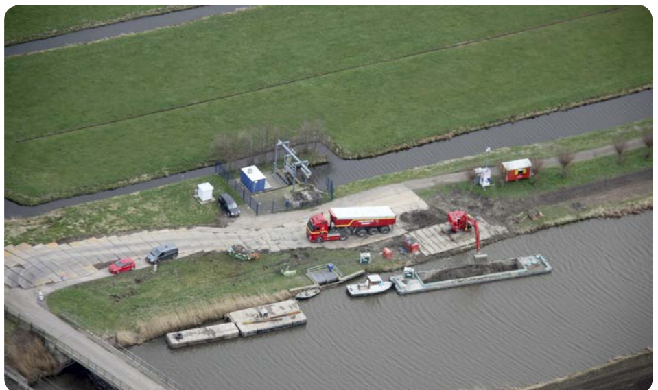
De verbetering van de kade
