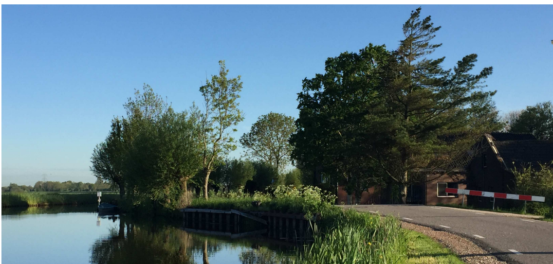
Afb. 2.6: damwand bij kruisende waterleiding
