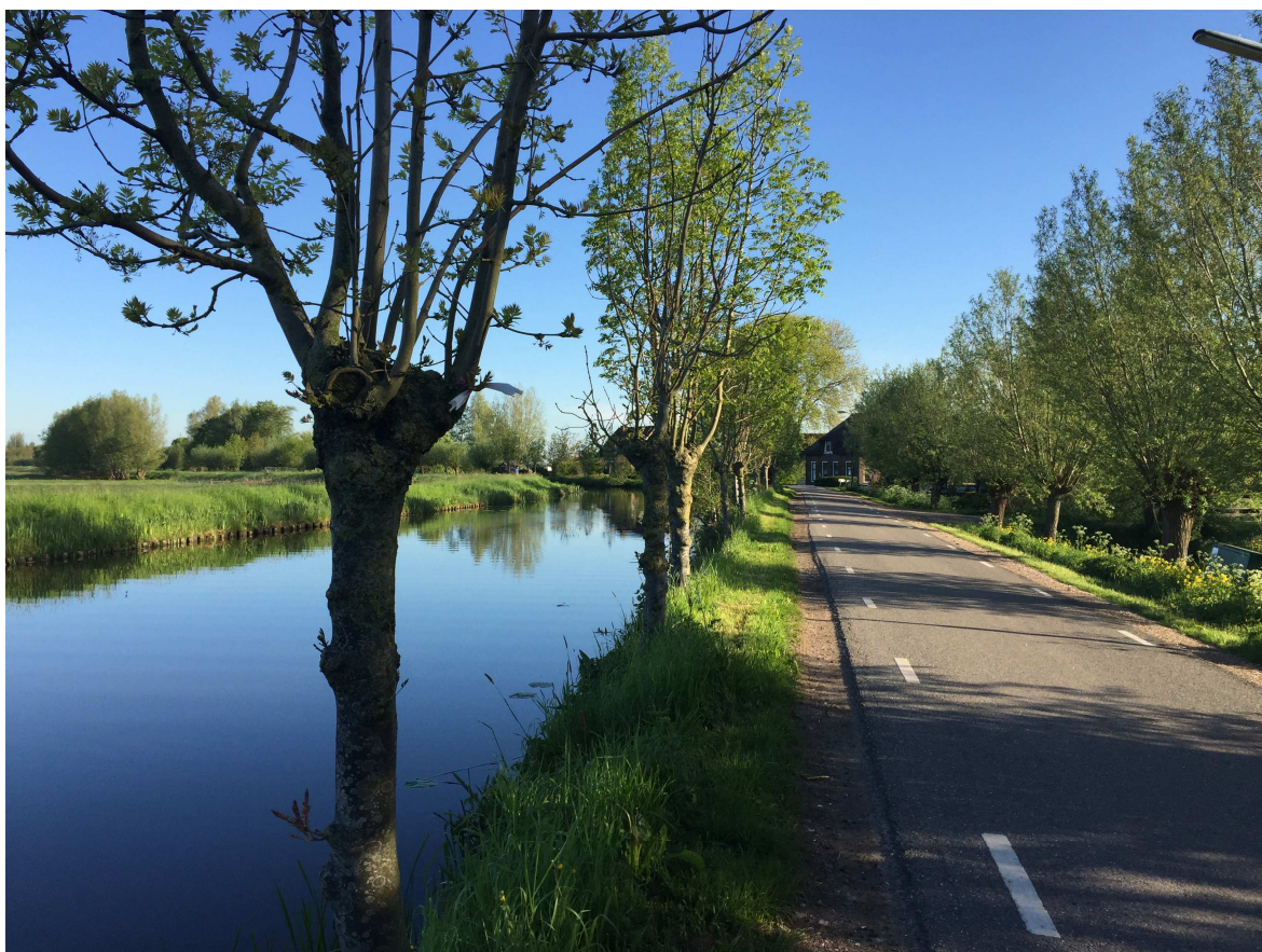
Afb. 2.2: Noordelijk deel kadevak 218B-1 met cultuurhistorische bebouwing
